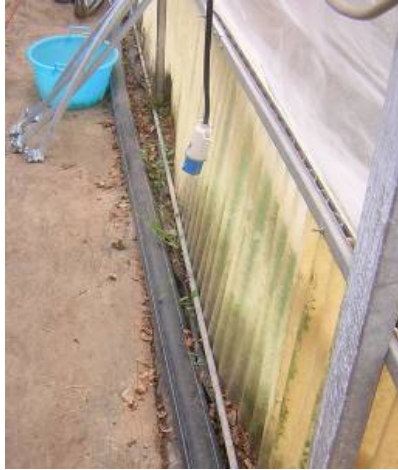
Basamento in PRFV (Poliestere rinforzato con fibra di vetro)
